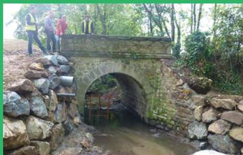
Soumis à l'érosion causée par le Jonan et/ou le Mornantet, les ponts de Chablenas, de la Piasse et de la Tannerie font l'objet de travaux de rénovation et de consolidation conduits par la commune, la COPAMO, le Département et le SMAGGA.
